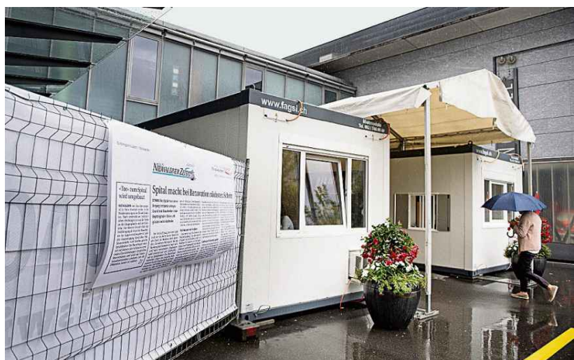
Mit einem Gitter (links) ist der Hauptzugang abgesperrt. Rechts die provisorischen Container vor dem Notfalleingang.
