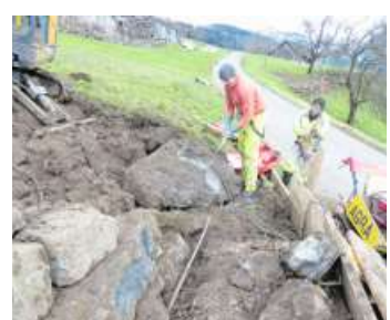
Arbeiter sanieren die Trockenmauern in Ennetbürgen.
