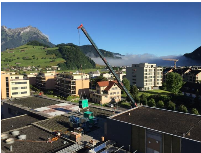
Anlieferung Lüftungsanlage über Helikopterlandeplatz KSNW
